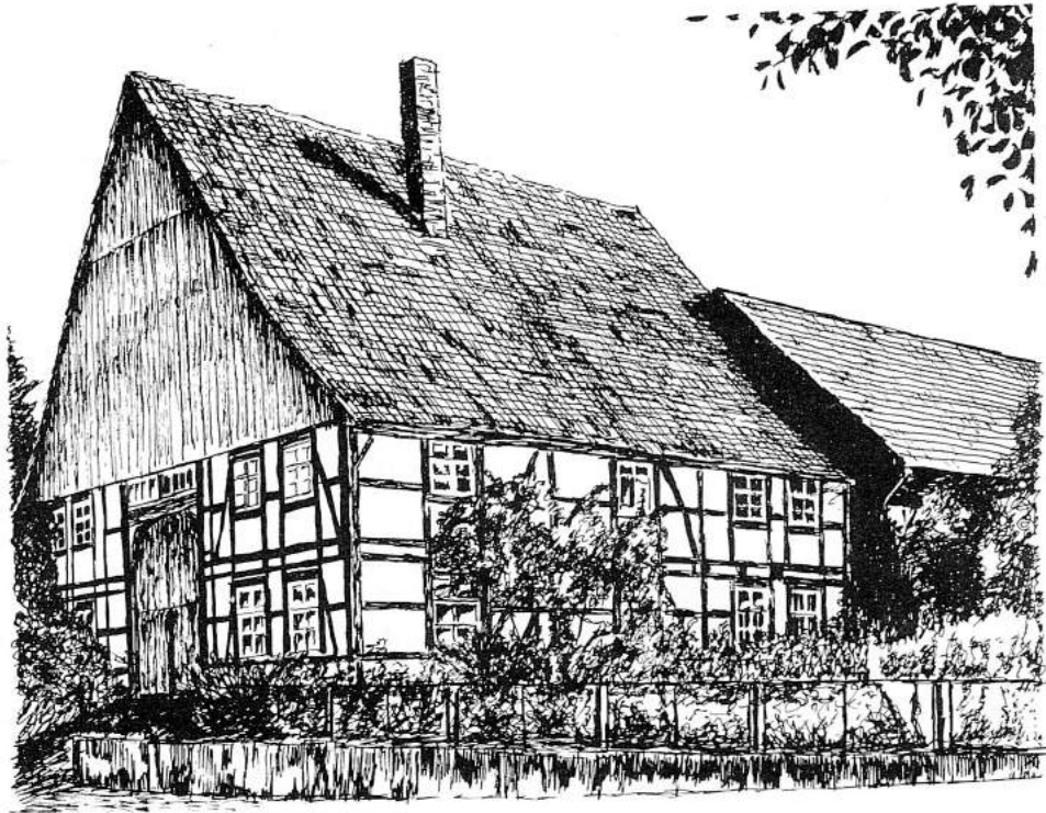
Einst ein schönes Fachwerkhaus. Heute nagt hier sichtbar der Verfall
