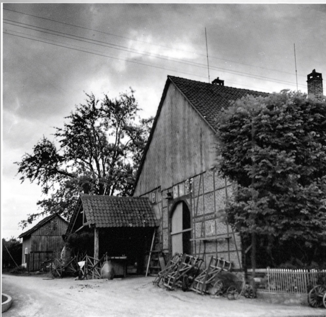
Alte Dorfschmiede Heinrich Henze mit Bauernhausdiele. Apfelweg, Ecke Griesbemer Straße.
