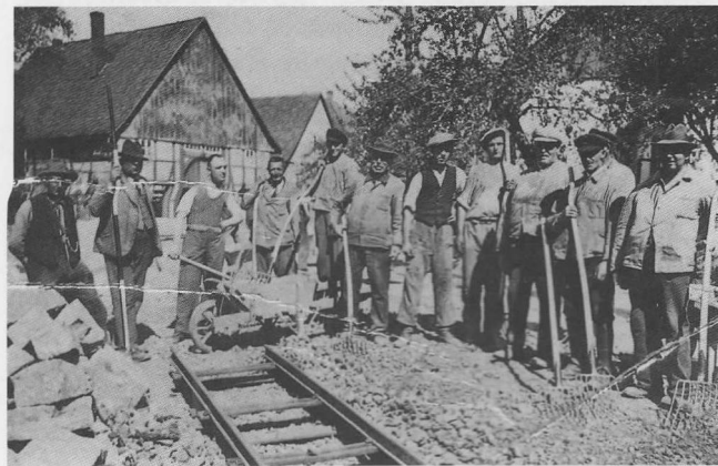
Arbeitsgruppe beim Straßenbau an der Griebemer Straße.
