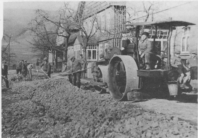
Albert Rostmann, Wegemeister mit Arbeitsgruppe und Dampfwalze beim Straßenbau „Auf dem Fohre“.
