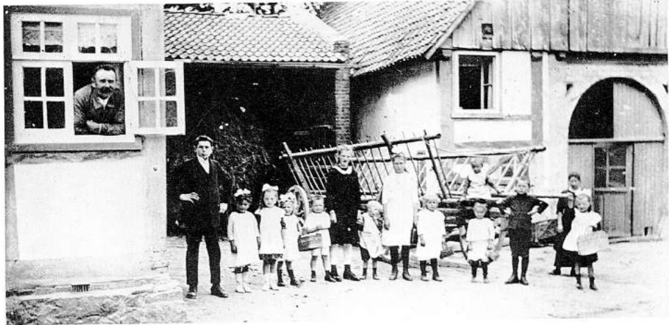
An der Griebemer Straße 1919. Links Haus Walbach, heute Fischer.
