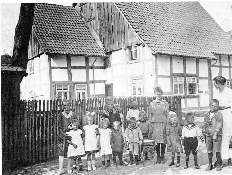
Haus Walbach, heute Griebemer Straße Nr. 9 im Jahr 1919.
