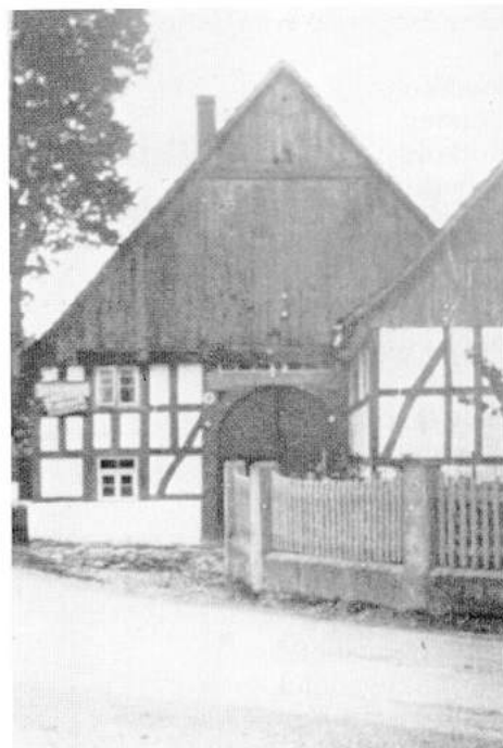
In dem Anbau rechts, war früher die Nagelschmiede Lönnecker. Heute Haus Griebemer Straße Nr. 42
